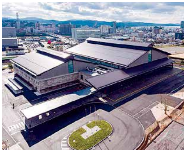
松江市総合体育館
