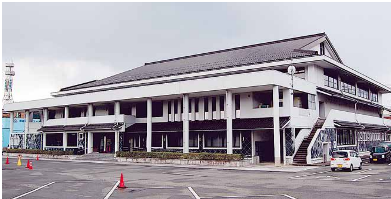
島根県立石見武道館全景
